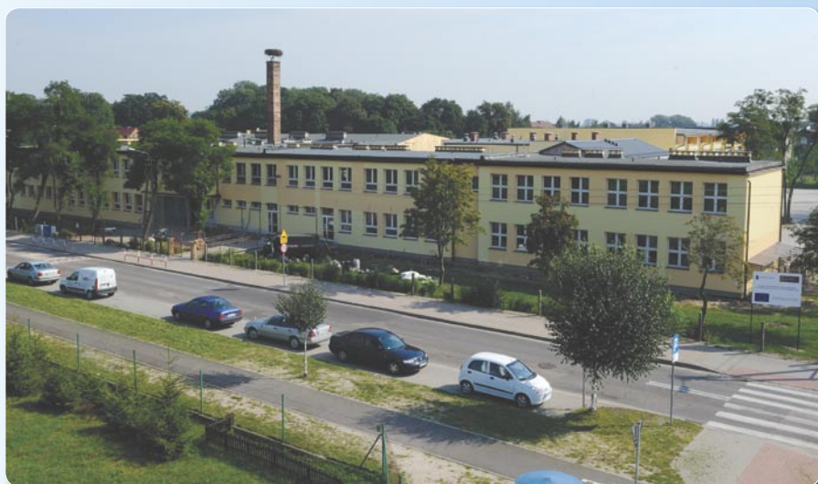
Termomodernizacja ZS nr 2. Koszt ogółem 1 508 000 zł.
