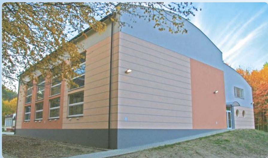
Budowa sali przy SP nr 5. Koszt ogółem: 2 570 370 zł
