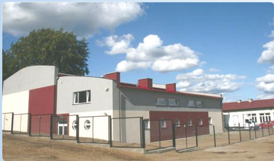
Budowa sali przy SP nr 6. Koszt 2 314 450 zł
