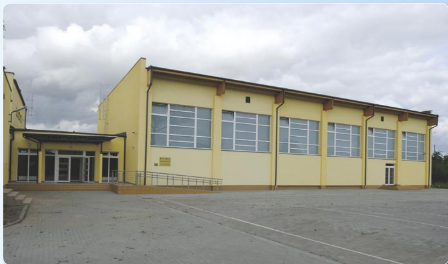
Budowa sali przy ZS nr 2. Koszt ogółem: 4 200 000 zł.
